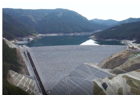
小石原川ダム
