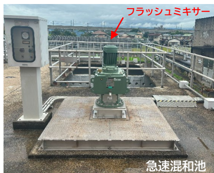
急速混和池のフラッシュミキサー（更新後）
