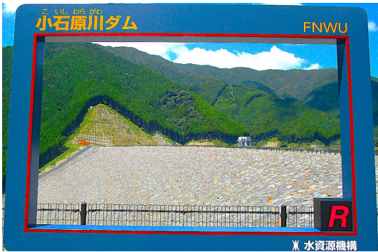
ダムカード型フレームを用いた写真
