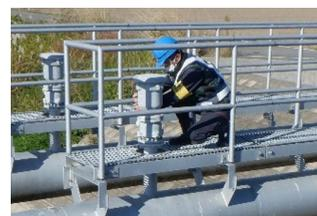
補修弁の動作確認
