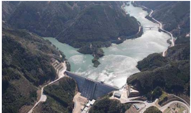
合所ダム Gousyo Dam
