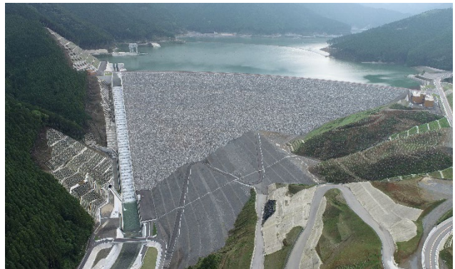
小石原川ダム Koishiwara-gawa Dam
