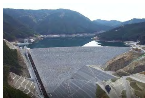
小石原川ダム
