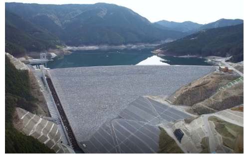
小石原川ダム
