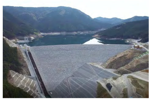
小石原川ダム
