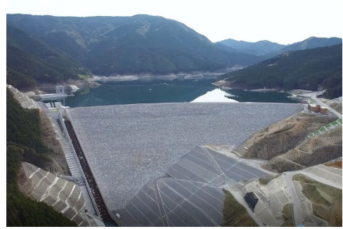
小石原川ダム
