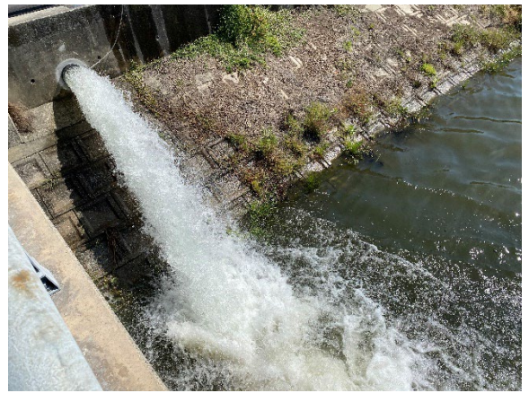
洗管作業の様子
