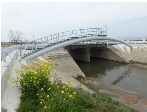
整備した水管橋
