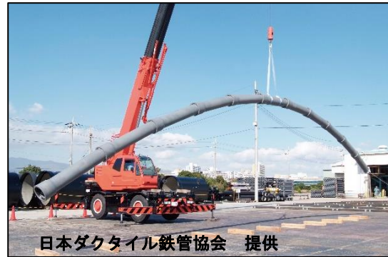
写真4.2.1.1 耐震管の吊り上げ状況
