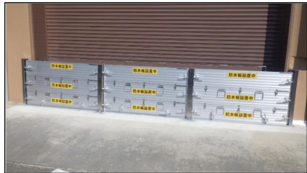
写真 2.4.1 浸水対策の状況
