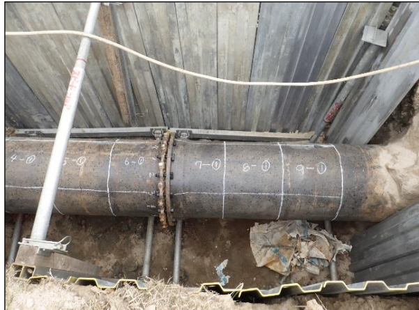
写真 4.3.2.1 管体調査状況
