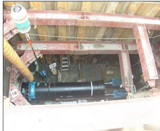
写真4.2.1.2 管路布設状況
