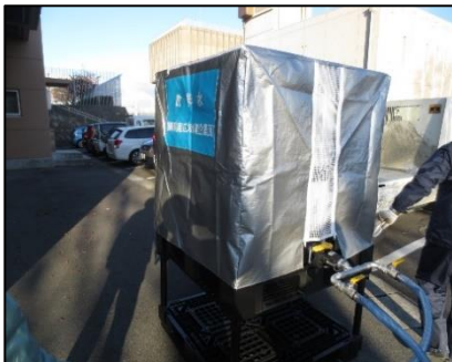
写真4.2.2.1 組立式給水タンク
