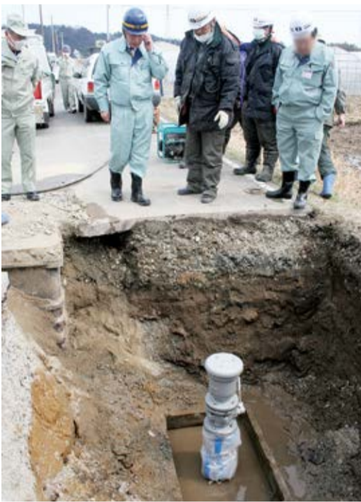
東日本大震災の漏水修理の様子
