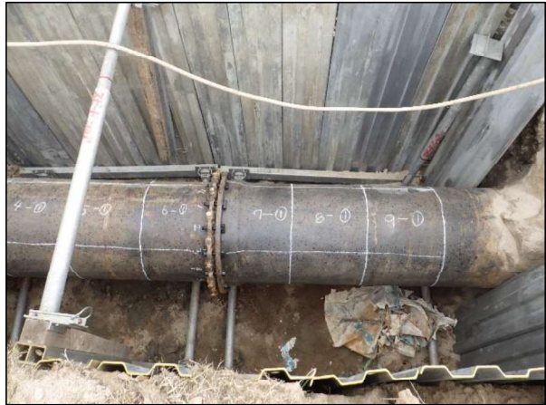
写真 4.3.2.1 管体調査状況
