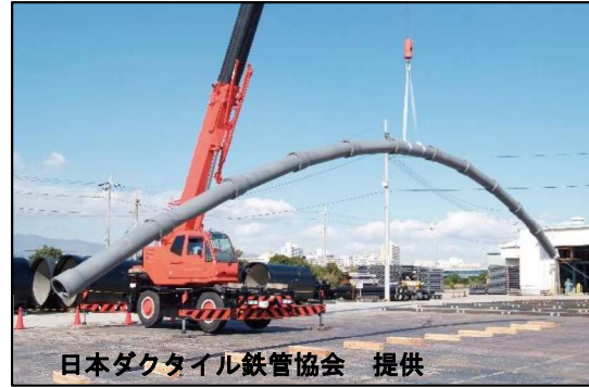
写真 4.2.1.1 耐震管の吊り上げ状況
