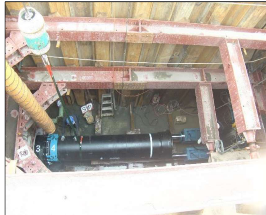
写真 4.2.1.2 管路布設状況
