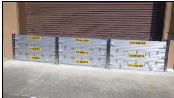
写真2.4.1 浸水対策の状況
