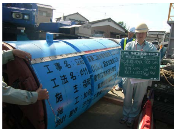
推進工事（推進機及び本管挿入状況）
