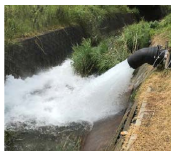
洗管作業の様子
