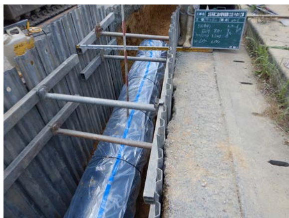
開削工事（掘削及び管布設状況）
