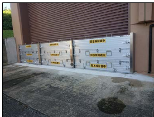
止水板設置状況
