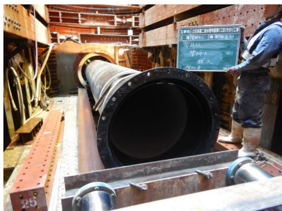
推進工事（推進機及び本管挿入状況）
