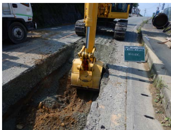
開削工事（掘削及び管布設状況）
