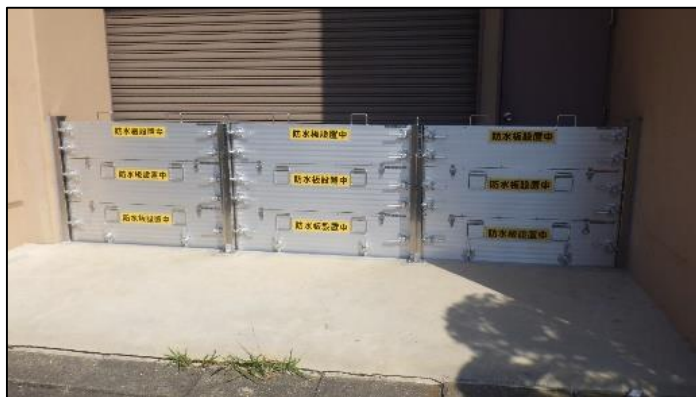
脱着式止水板の設置状況
