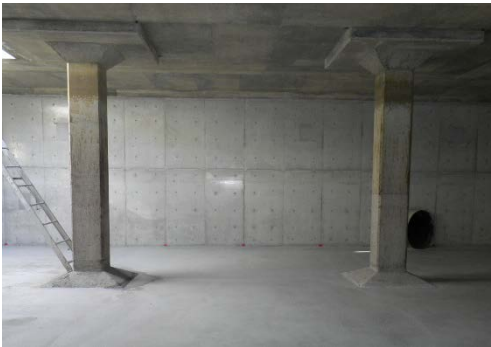
浄水池（水道水を貯める池）の耐震補強 （壁と床をコンクリートで増強）
