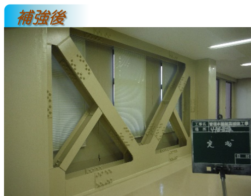
管理本館（鉄骨ブレース接着工法）
