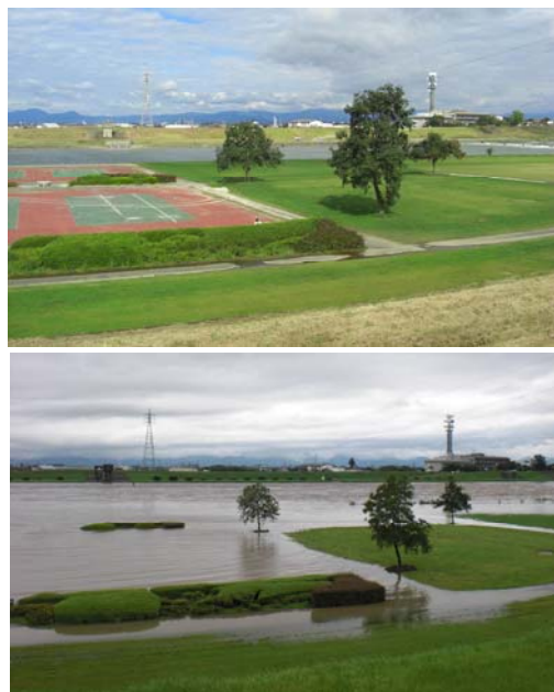
筑後川（東櫛原取水口付近）の状況 上：平常時 下：増水時
